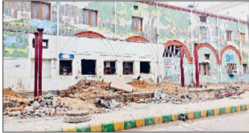
सोनीपत। स्टेशन परिसर के मुख्य प्रवेश द्वार पर निर्माणाधीन नए भवन के साथ बना पुराना भवन।
