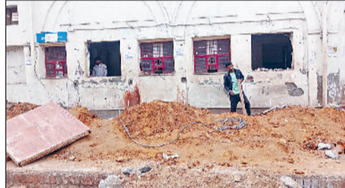
सोनीपत। स्टेशन के पुराने भवन में काम करते मजदूर।
